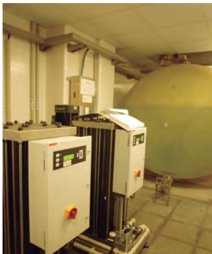
Foto 6.29. y 6.30. Sala de tratamiento de agua: doble ósmosis inversa y sistema de filtrado.
