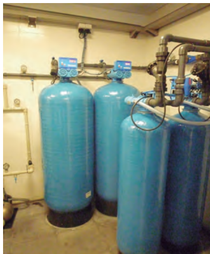
Foto 6.29. y 6.30. Sala de tratamiento de agua: doble ósmosis inversa y sistema de filtrado.
